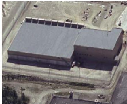
Figure A3-5 & A3-6 Exemple d'une installation de stockage à sec sur le site d'un complexe nucléaire – Bâtiment d'entreposage en surface et conteneurs de stockage à sec
