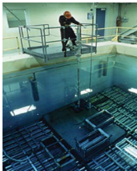
Figure A3-4 : Exemple d'entreposage dans des piscines à combustible irradié sur le site d'un complexe nucléaire
