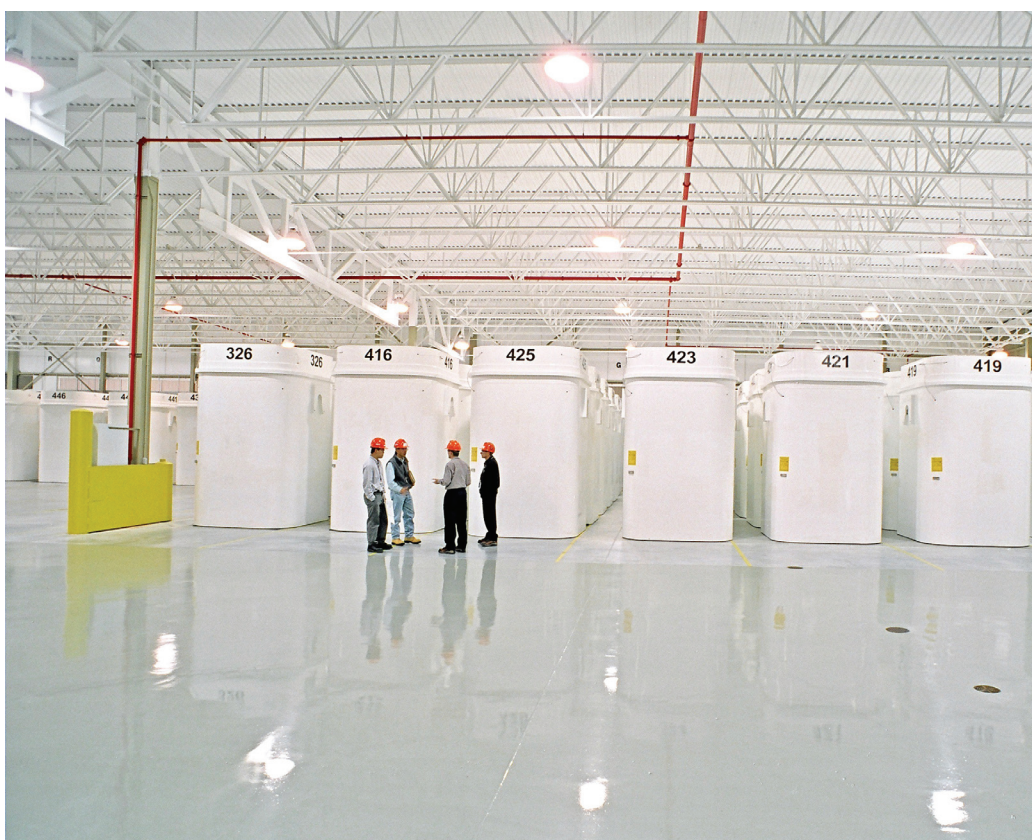
Figure 2 : Conteneurs de stockage à sec au centre de gestion des déchets Western d'OPG, à Tiverton en Ontario
